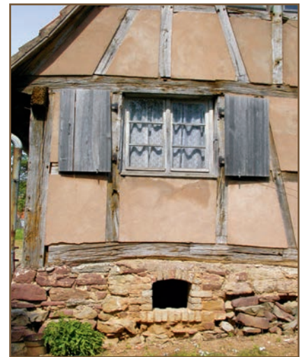
Mixité des matériaux : grès, brique, bois, torchis...
