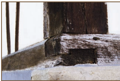
Assemblage au niveau du poteau cornier
