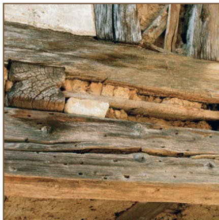
Système constructif d'un plancher : sablière, solive, poutre
