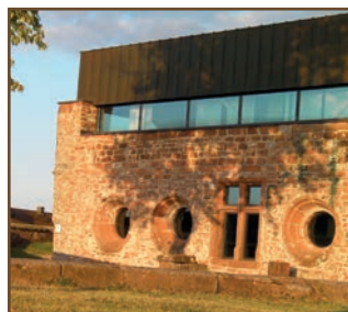
Bardage cuivre : château du Lichtenberg (architecte : Andréa Bruno)
