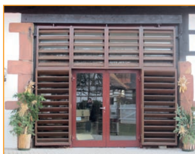
Aménagement d'un gîte : réinterprétation de la porte de grange avec vitrage et brise-soleil
