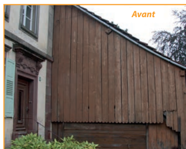
Aménagement d'un logement : reprise du bardage du schopf pour amener de la lumière
