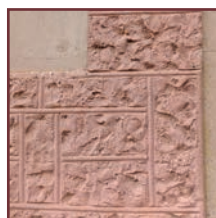
La pierre de taille ou son imitation en béton est utilisée en tant qu'élément enrichissant la façade (texture, couleur...). Lorsque la pierre de taille est récupérable sur place, elle est mise en œuvre comme ancrage de la tradition (soubassement, chaînage d'angle...).
