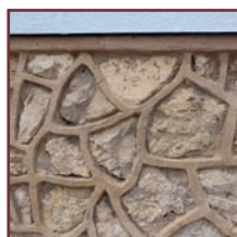
Les moellons grossièrement équarris appareillés avec des joints saillants se retrouvent en soubassement ou sur les murs de clôture.
