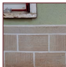
La pierre de taille ou son imitation en béton est utilisée en tant qu'élément enrichissant la façade (texture, couleur...). Lorsque la pierre de taille est récupérable sur place, elle est mise en œuvre comme ancrage de la tradition (soubassement, chaînage d'angle...).
