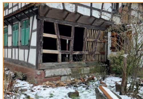
Ouverture d'une fenêtre dans le colombage en cours de travaux.
