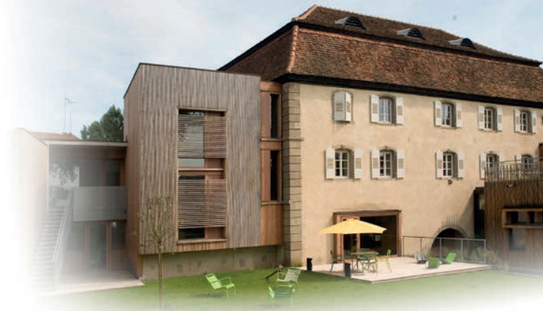
Aménagement d'un logement de gardien
